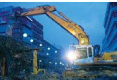
Qualifiziertes Baustoff-Recycling beginnt schon beim selektiven Rückbau von Bauwerken.
